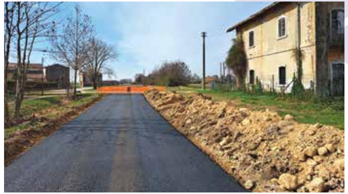
Pista ciclabile Treviso-Ostiglia, lavori in corso a Orgiano
